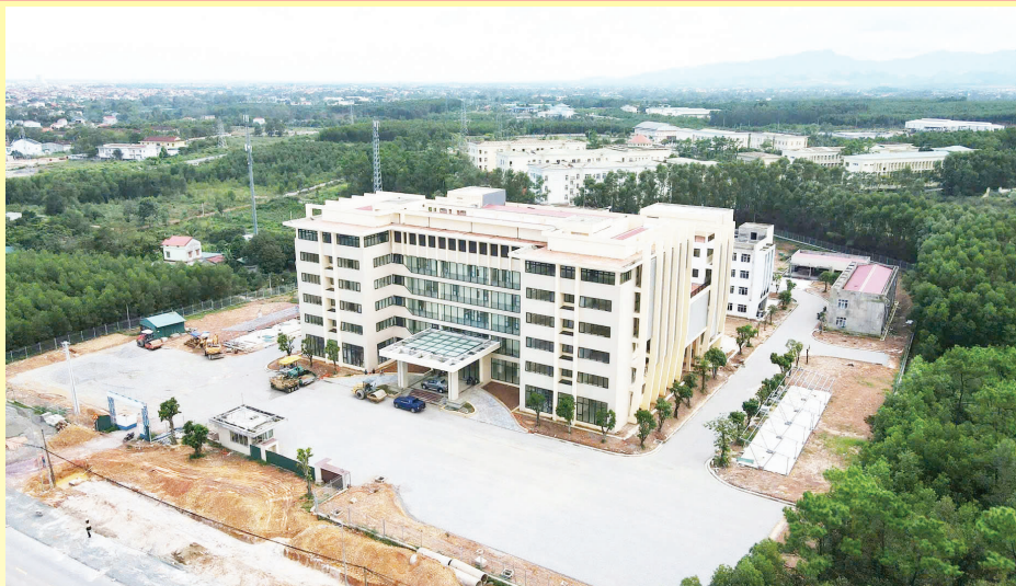
Dự án Trung tâm Kiểm soát bệnh tật tỉnh đang được gấp rút hoàn thiện
